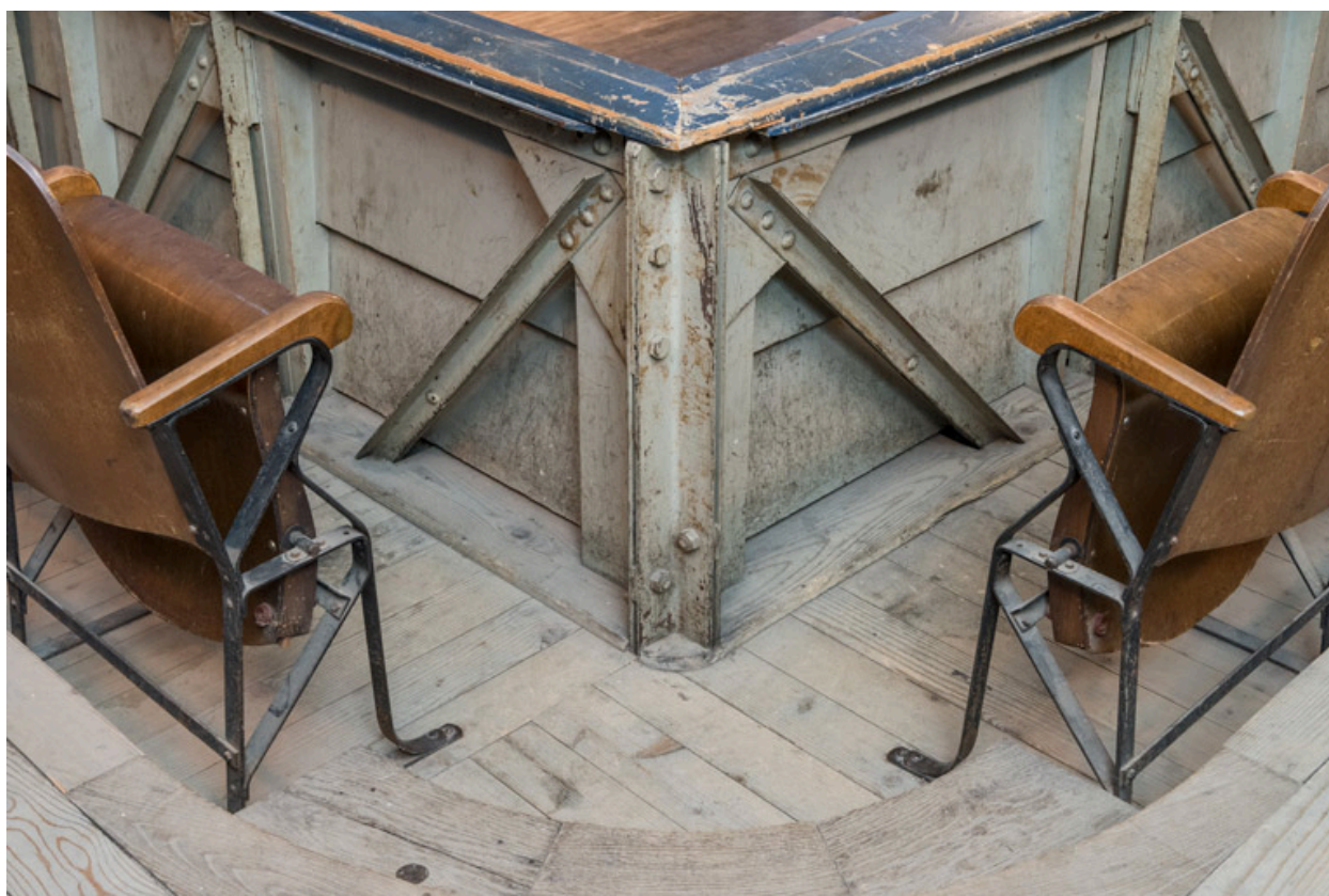
Balcon : structure métallique du garde-corps.
