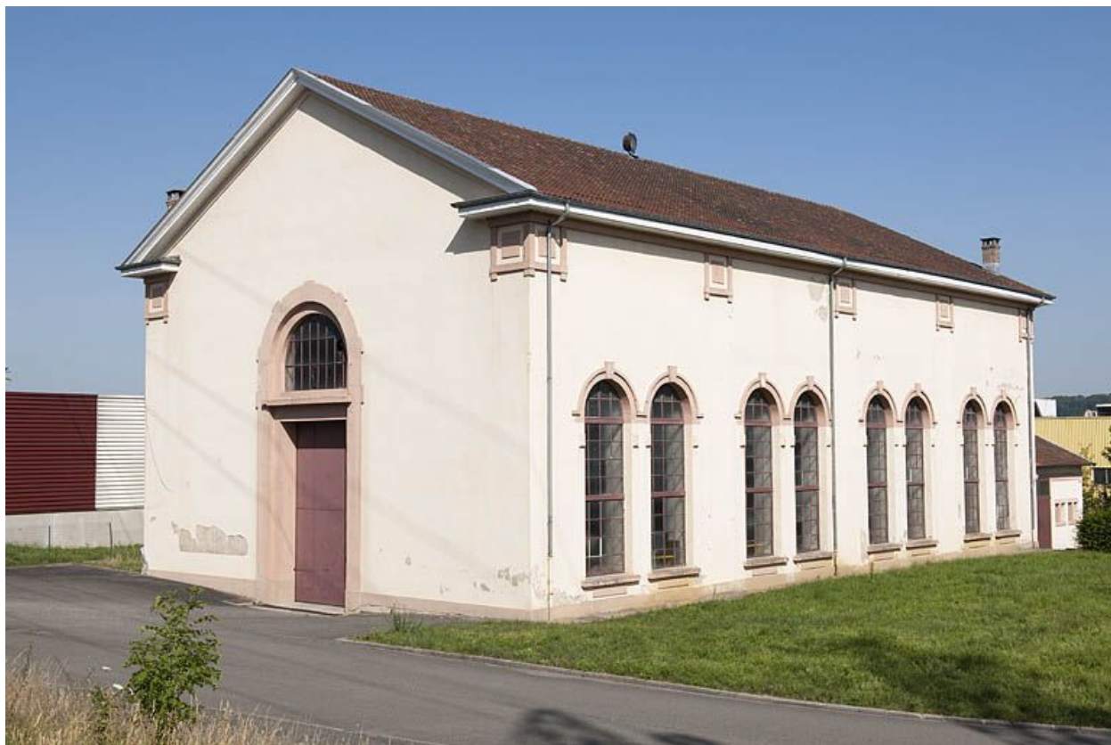
Salle des machines.
