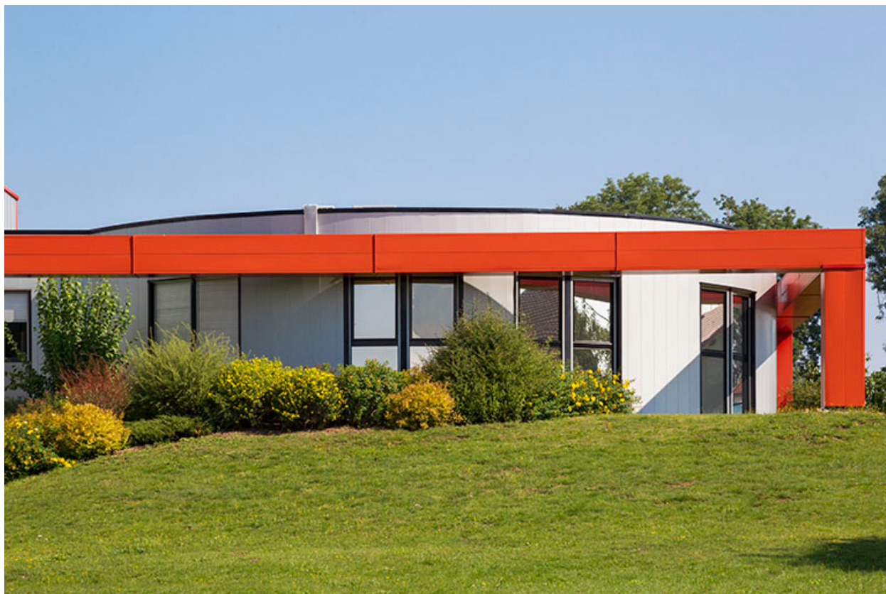
Façade postérieure : bureaux.
