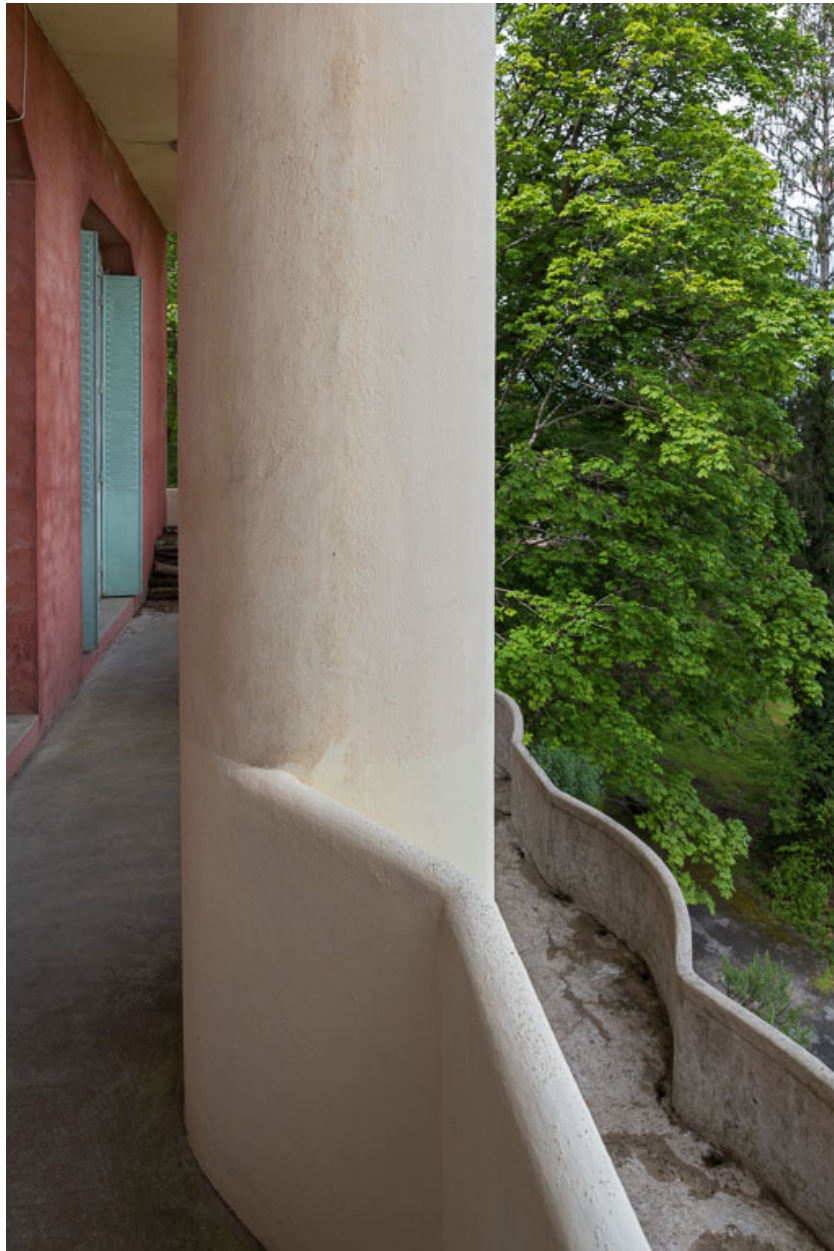
Balcon de la façade nord.
