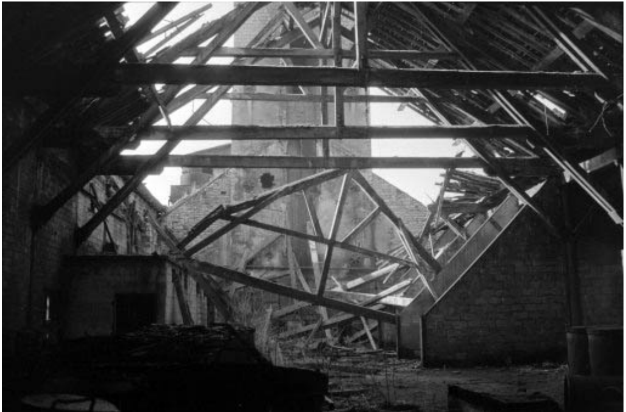
Atelier de fabrication : intérieur de la halle centrale (e2).
