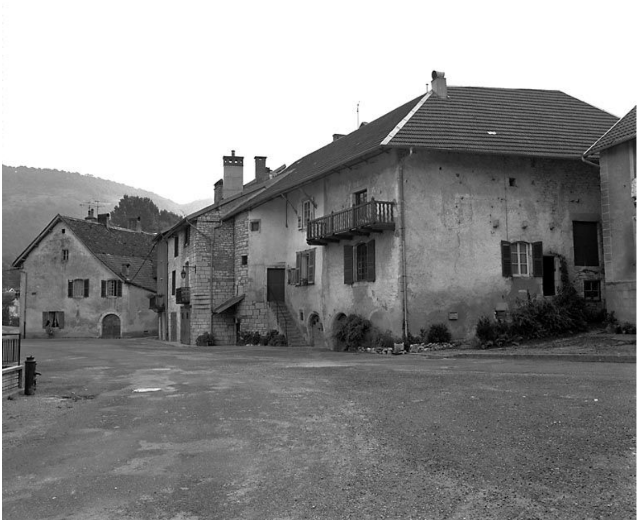
Façade antérieure et face latérale droite.
