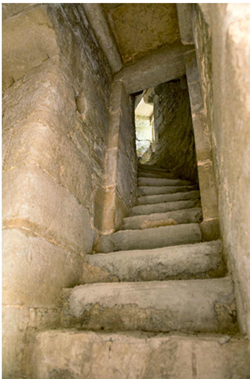
La tour ouest. Vue intérieure de l'escalier.
