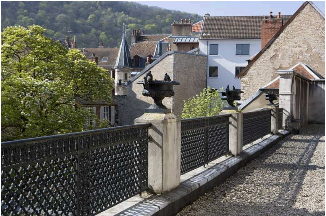
Vue du parapet bordant la terrasse du jardin d'hiver, côté jardin.
