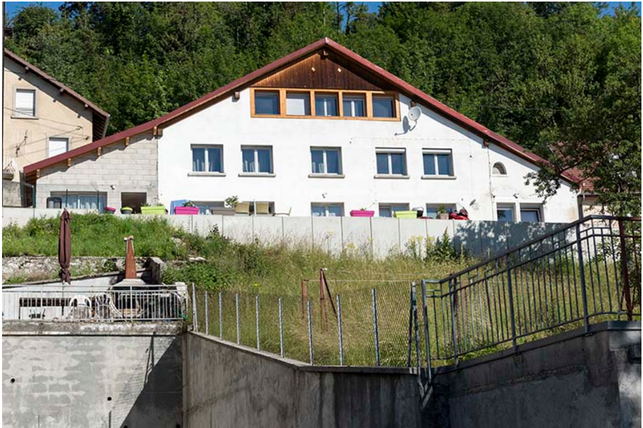
Façade est, vue en contre-plongée.
