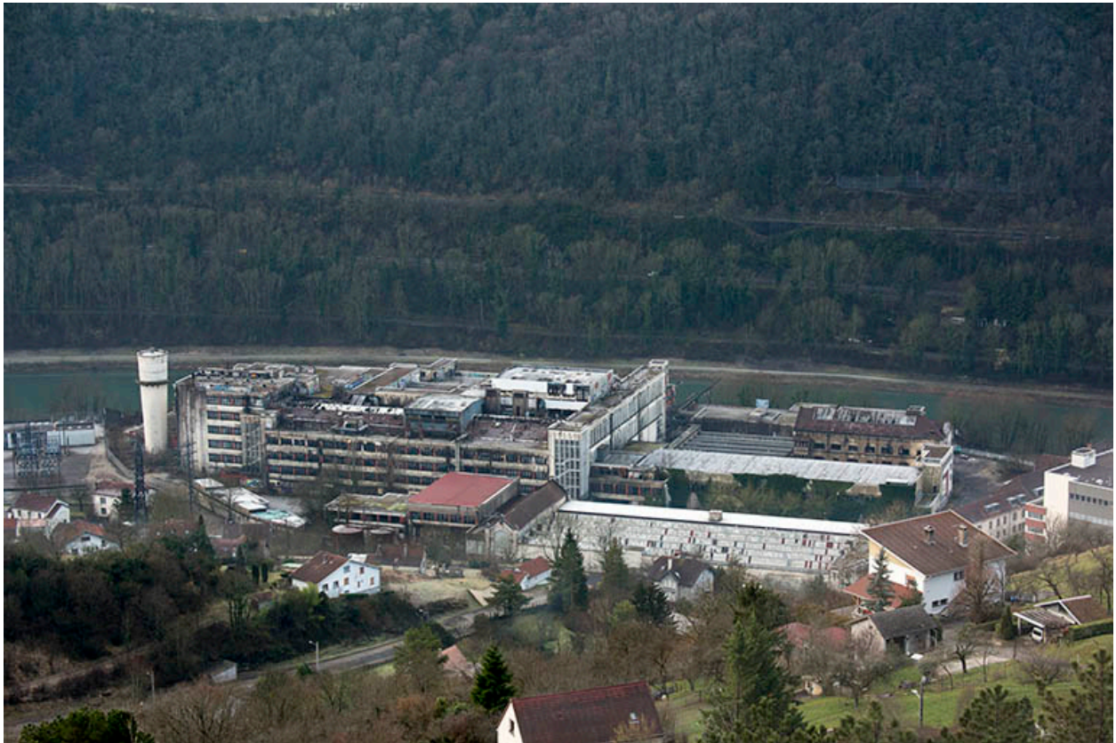
Etat en 2016. Usine A, vue du nord.
