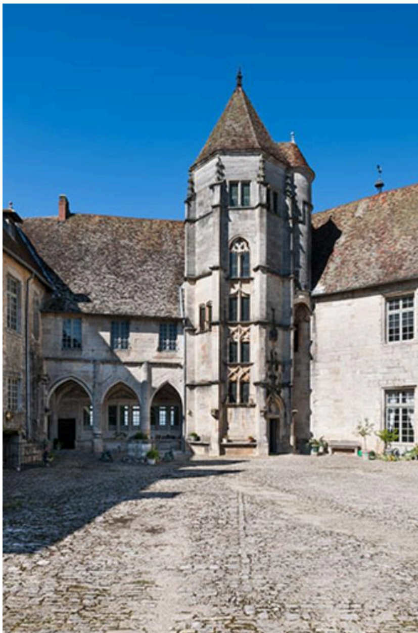
Le tour d'escalier et la galerie
