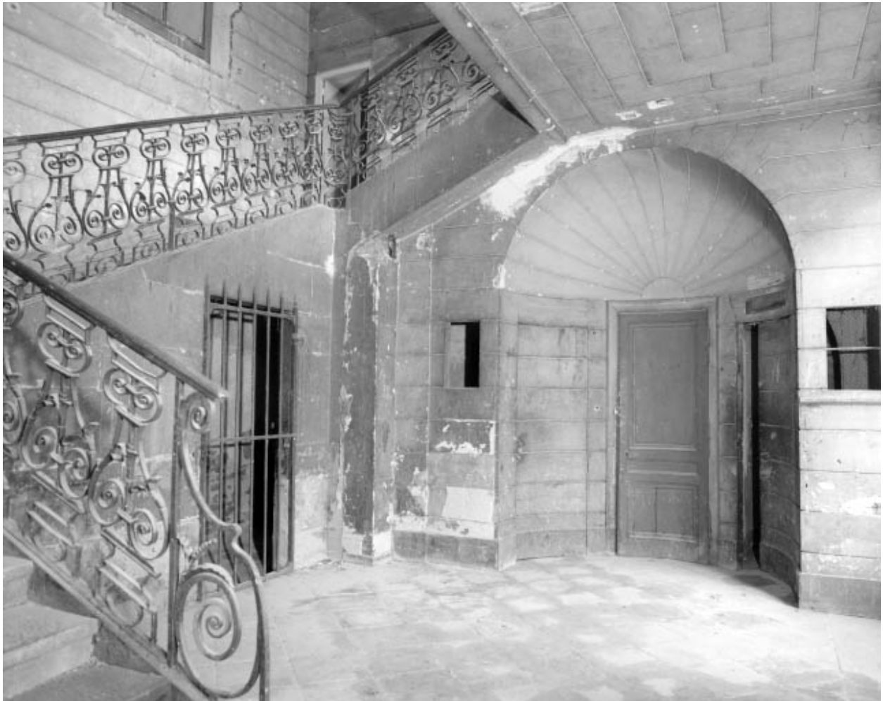
Intérieur : escalier d'honneur, vue d'ensemble en largeur.
