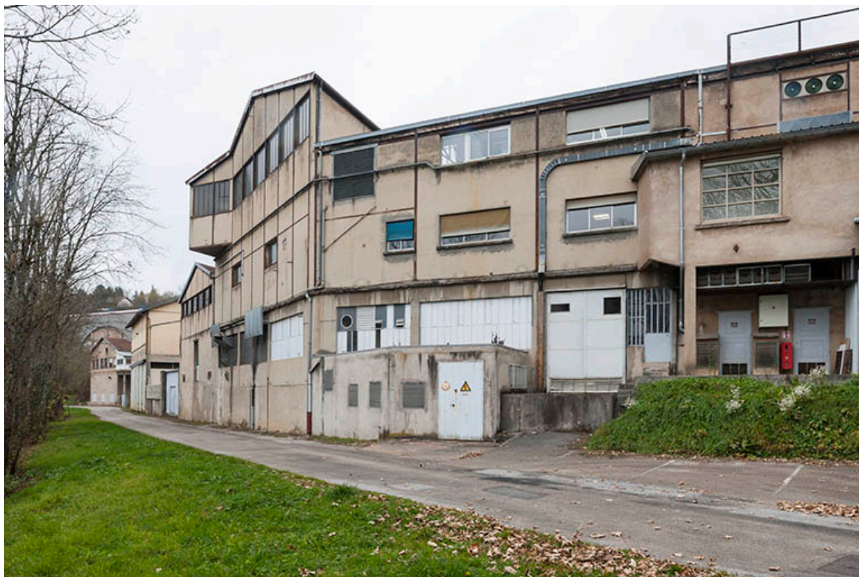
Façades sud de l'atelier de fabrication.
