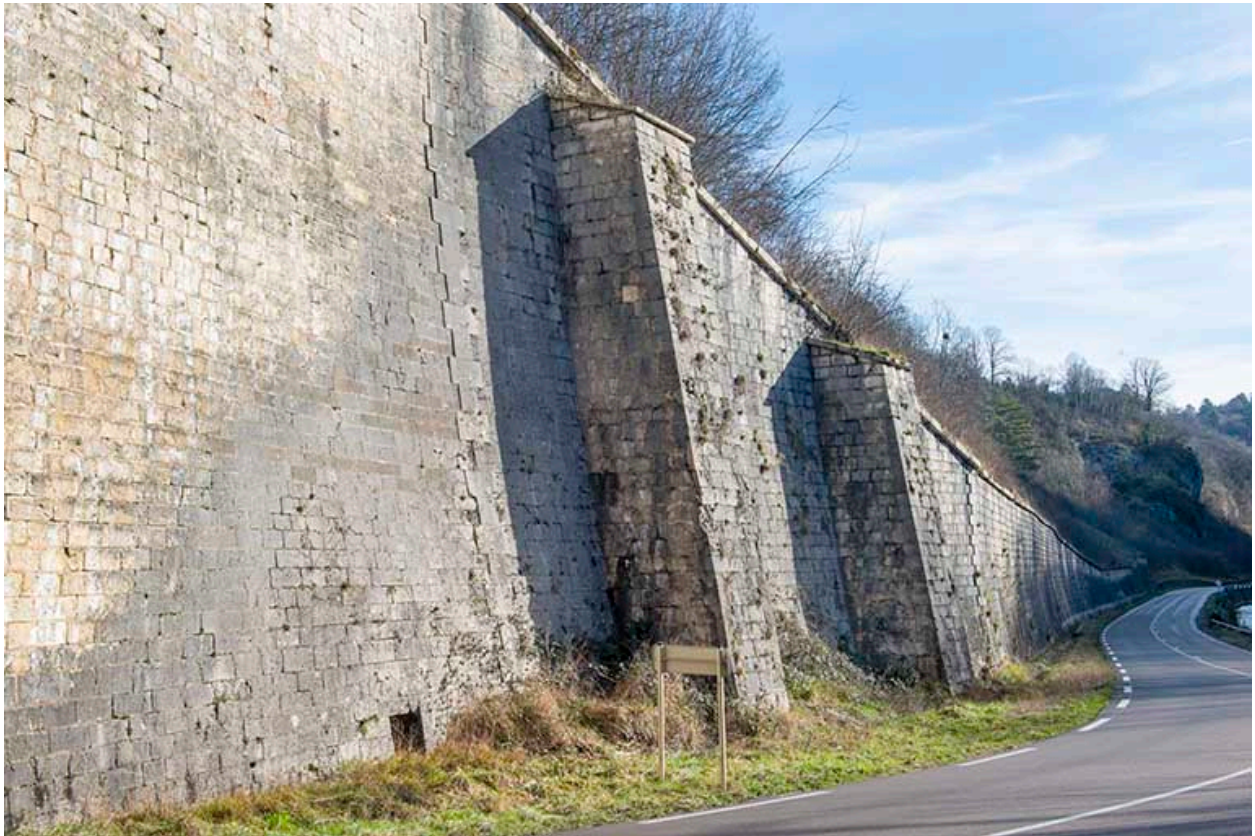
Mur de soutènement, depuis le pied du viaduc.
