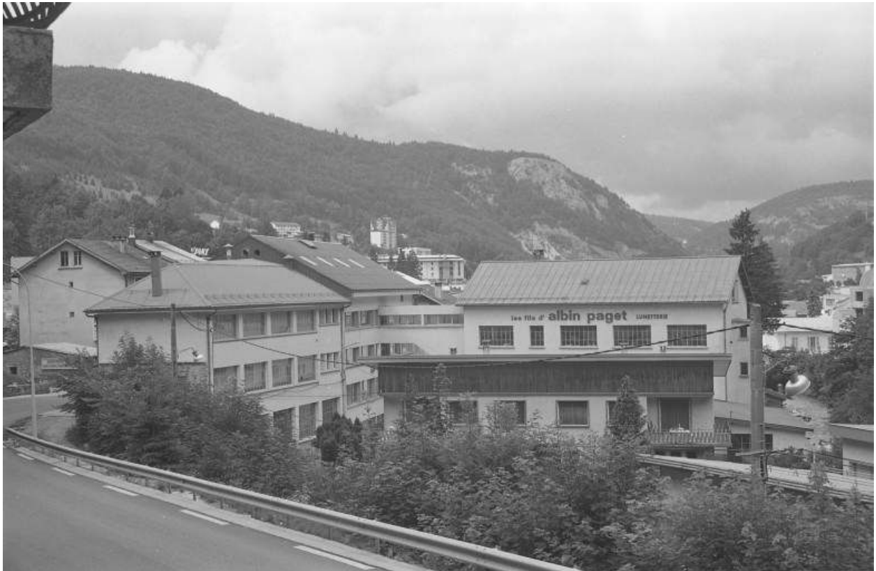
Bâtiments vus du sud.
