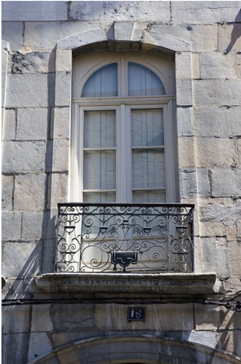
Logis principal : détail d'une fenêtre du premier étage sur rue.
