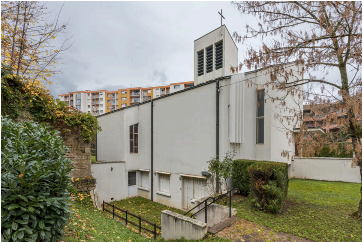
Vue de la façade sud (de trois-quarts).
