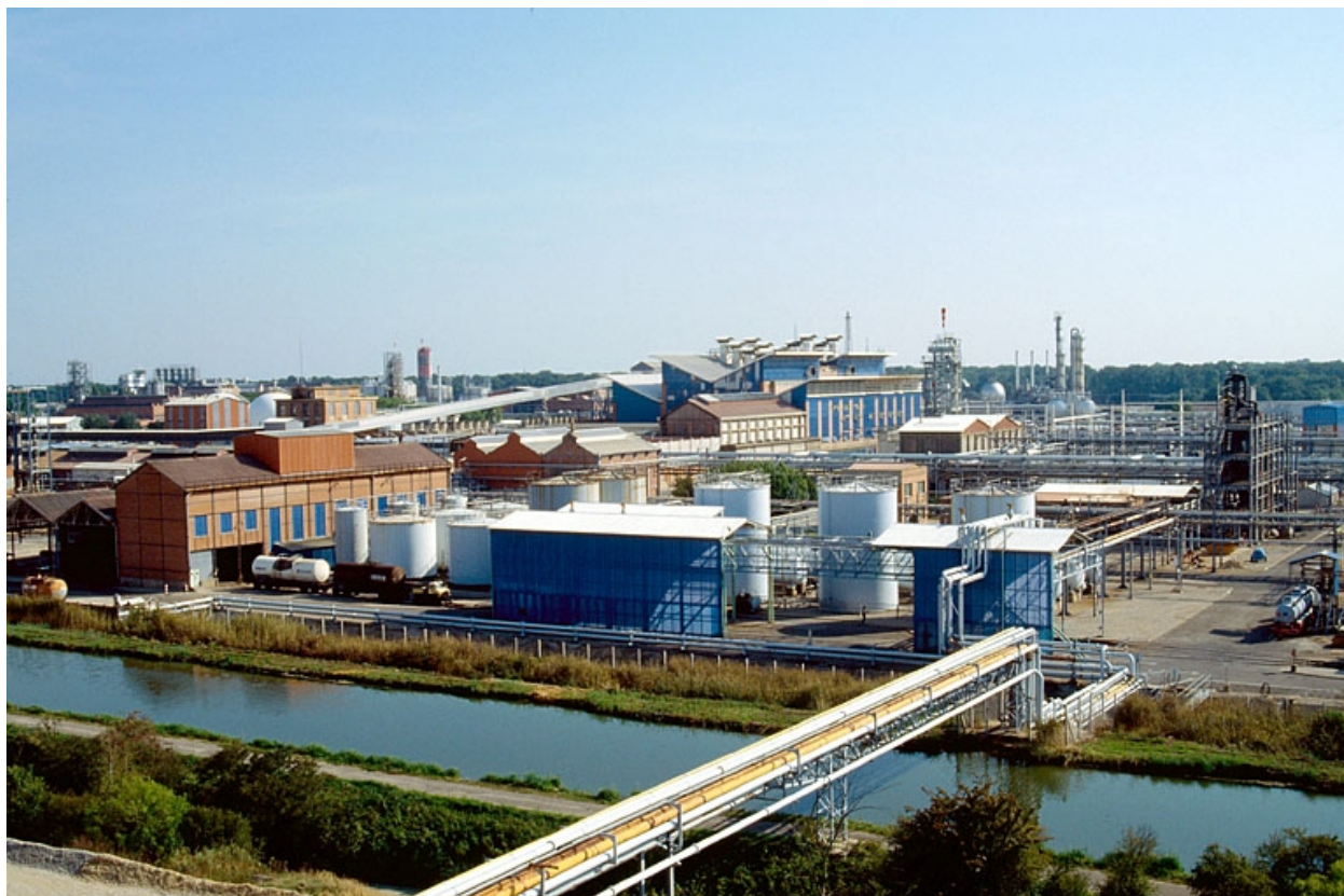
Division Electrolyse vue depuis le haut des bassins de décantation.
