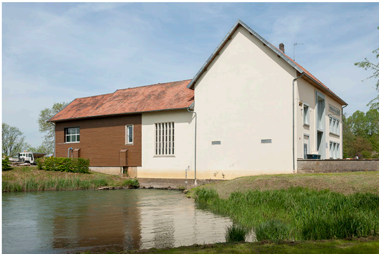
La centrale hydroélectrique vue depuis le sud.
