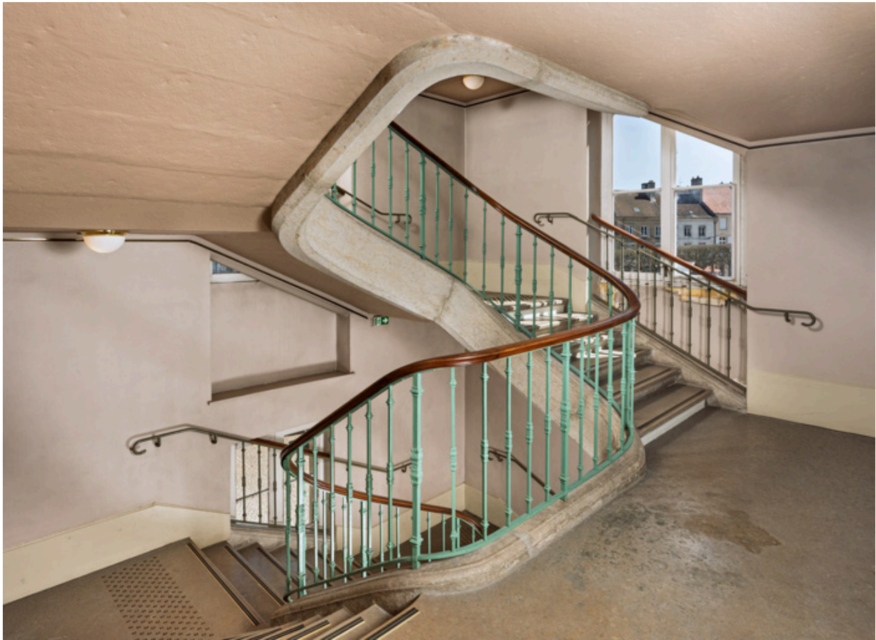
Escalier côté cour : un palier.
