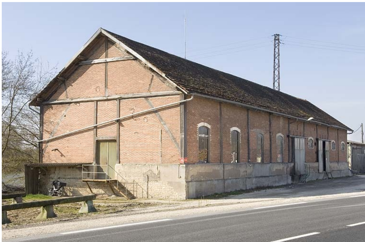
Magasin industriel depuis le nord-est.
