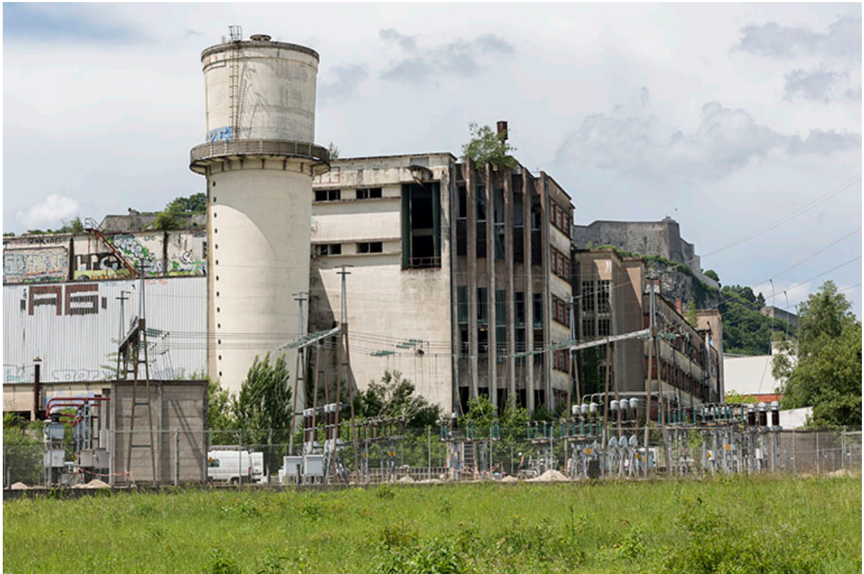
Etat en 2016. Usine A : façade nord de la filature nylon et château d'eau.
