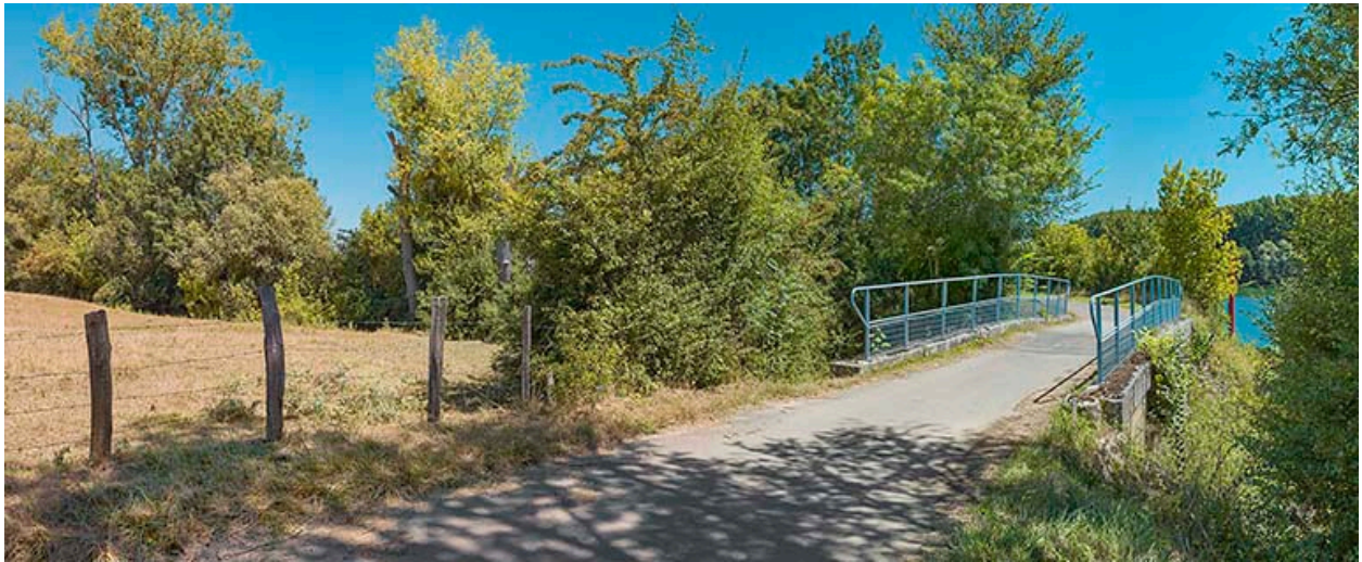
Vue d'ensemble, d'aval.
