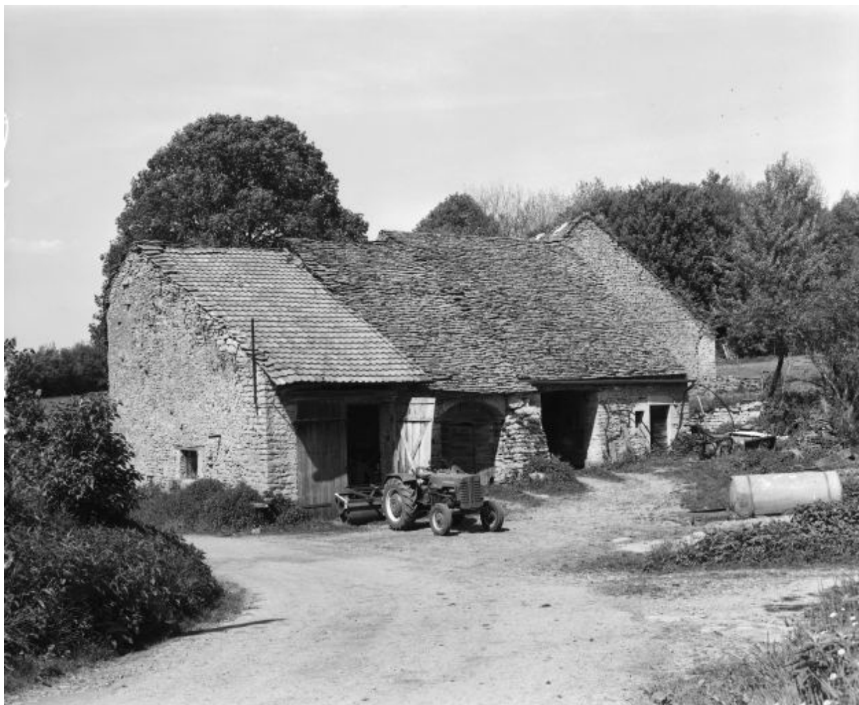
Vue générale de la façade antérieure.
