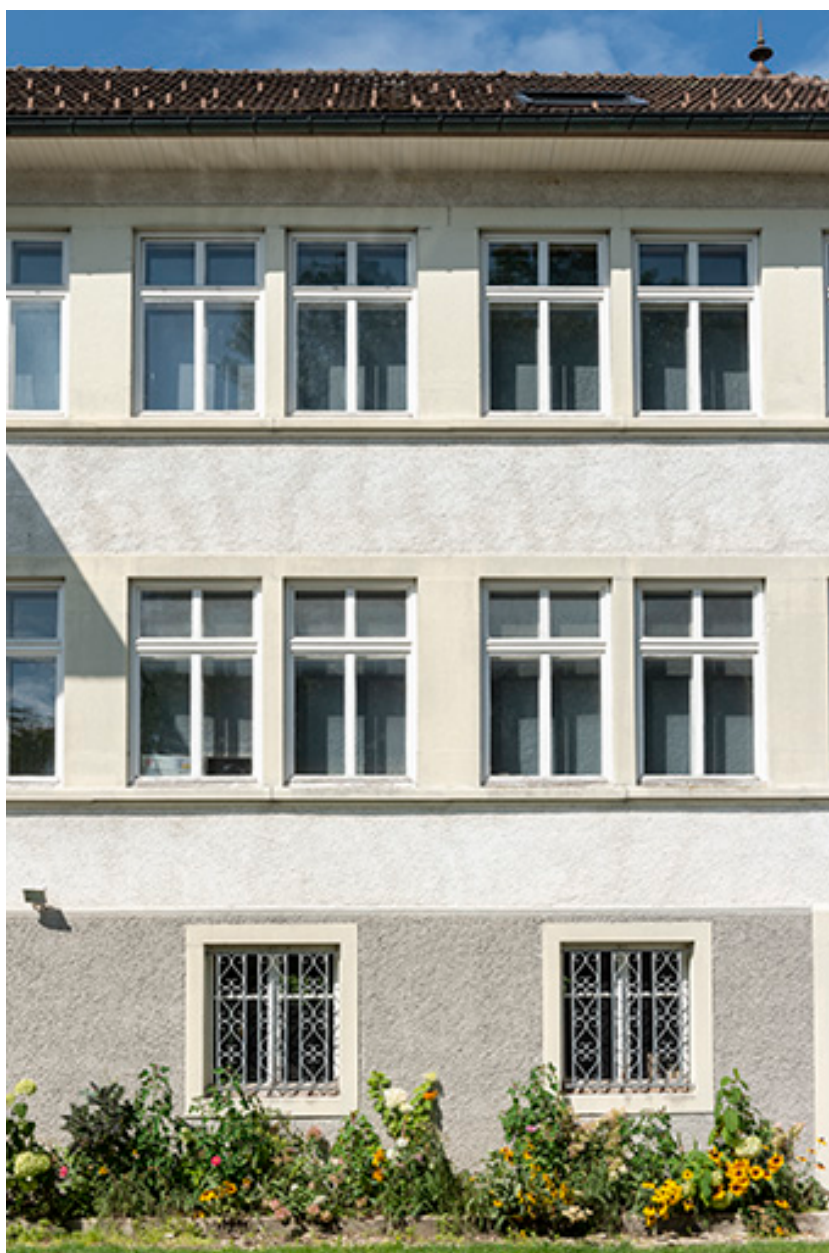
Usine : travées centrales de la façade antérieure.
