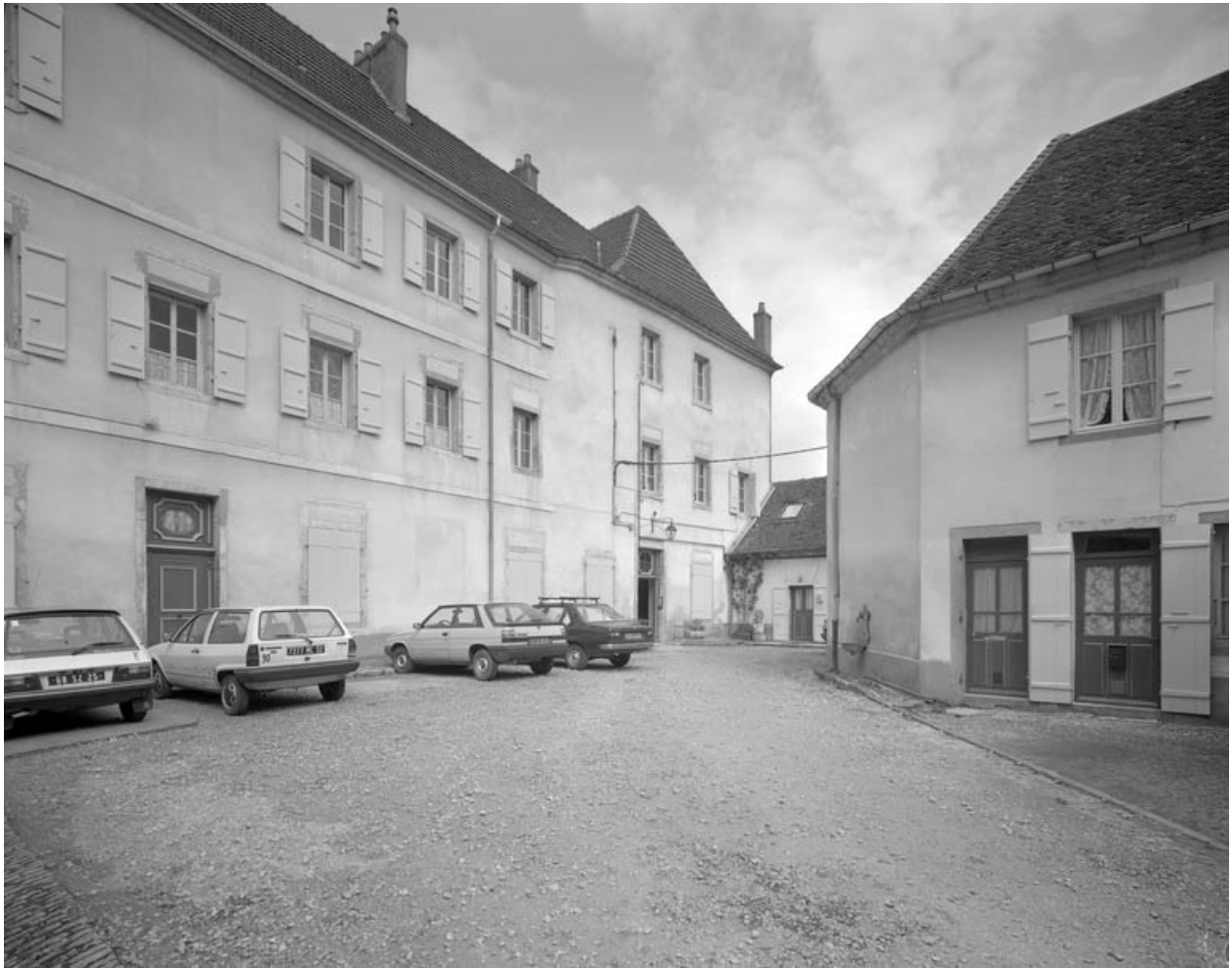
Façade antérieure du bâtiment principal : de trois quarts gauche.
