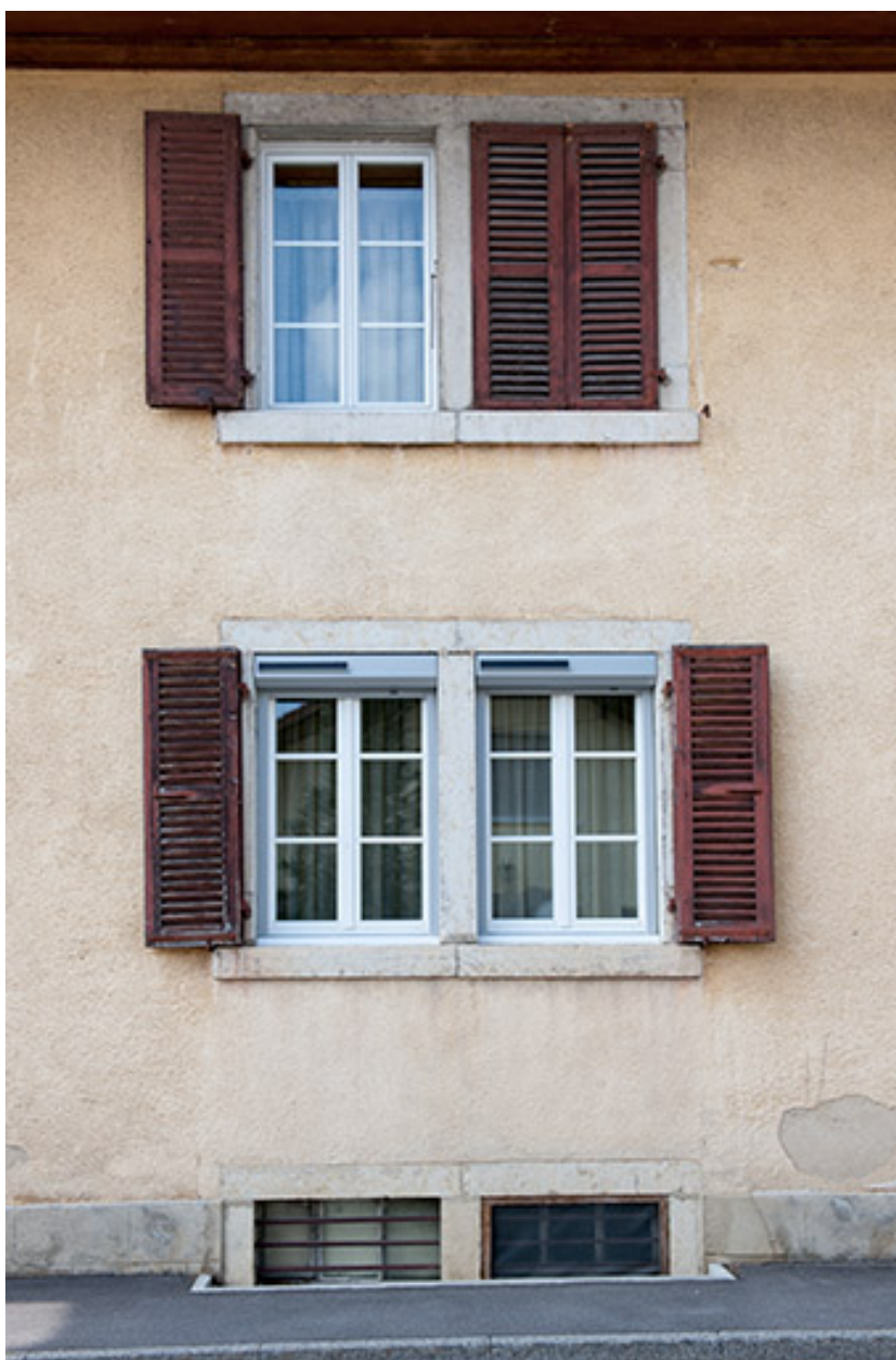
Logement patronal : fenêtres horlogères côté rue.
