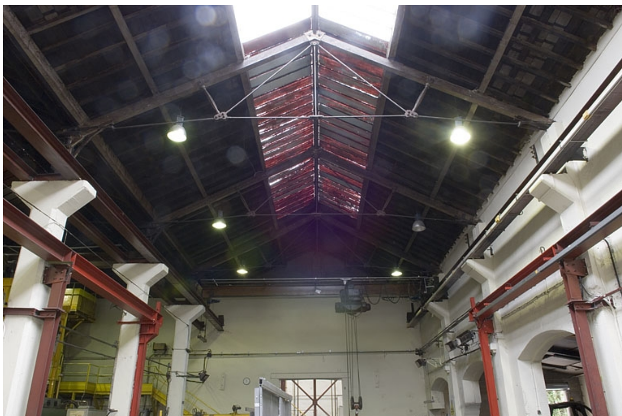
Intérieur de l'atelier et charpente Polonceau.
