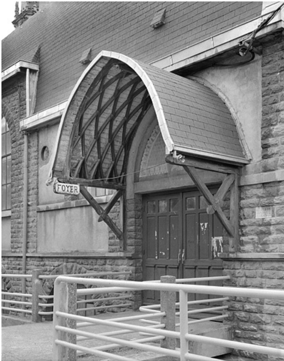
Entrée du gymnase.
