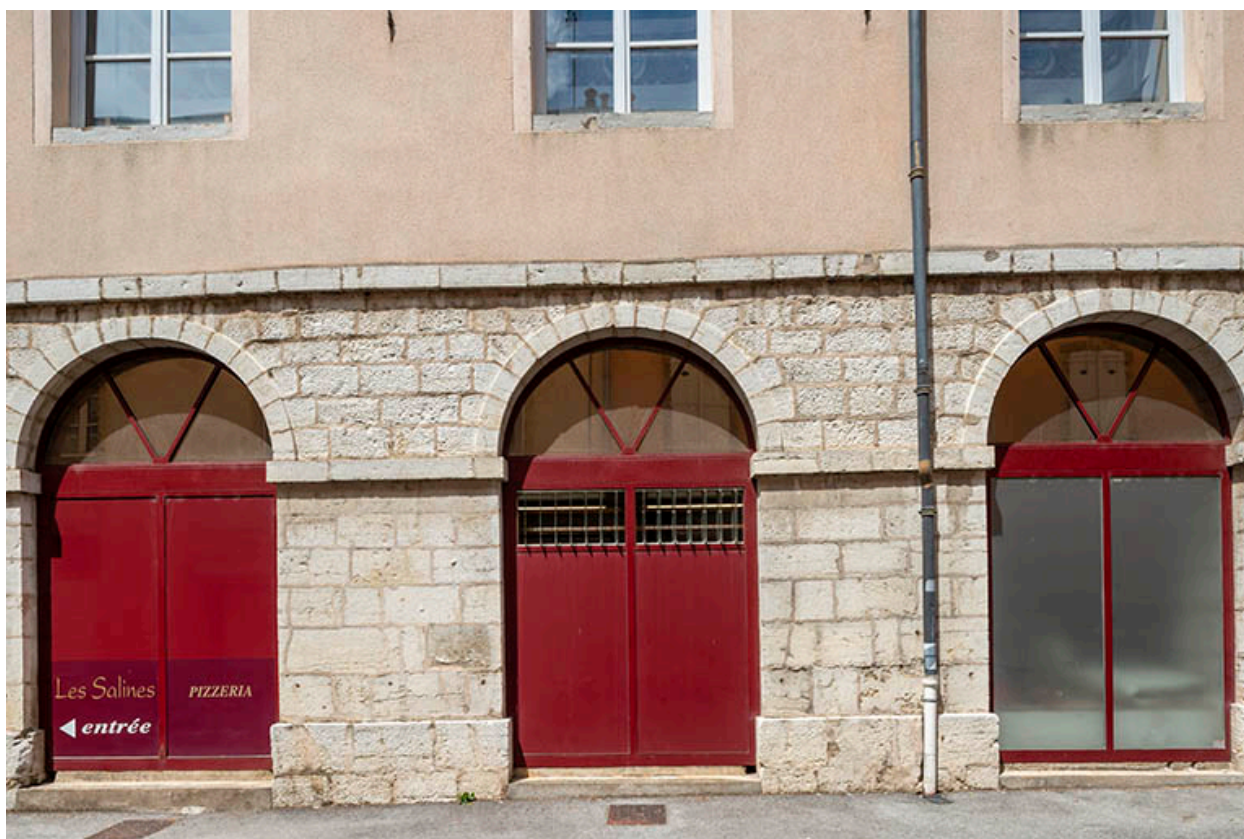
Portes de la façade sud.
