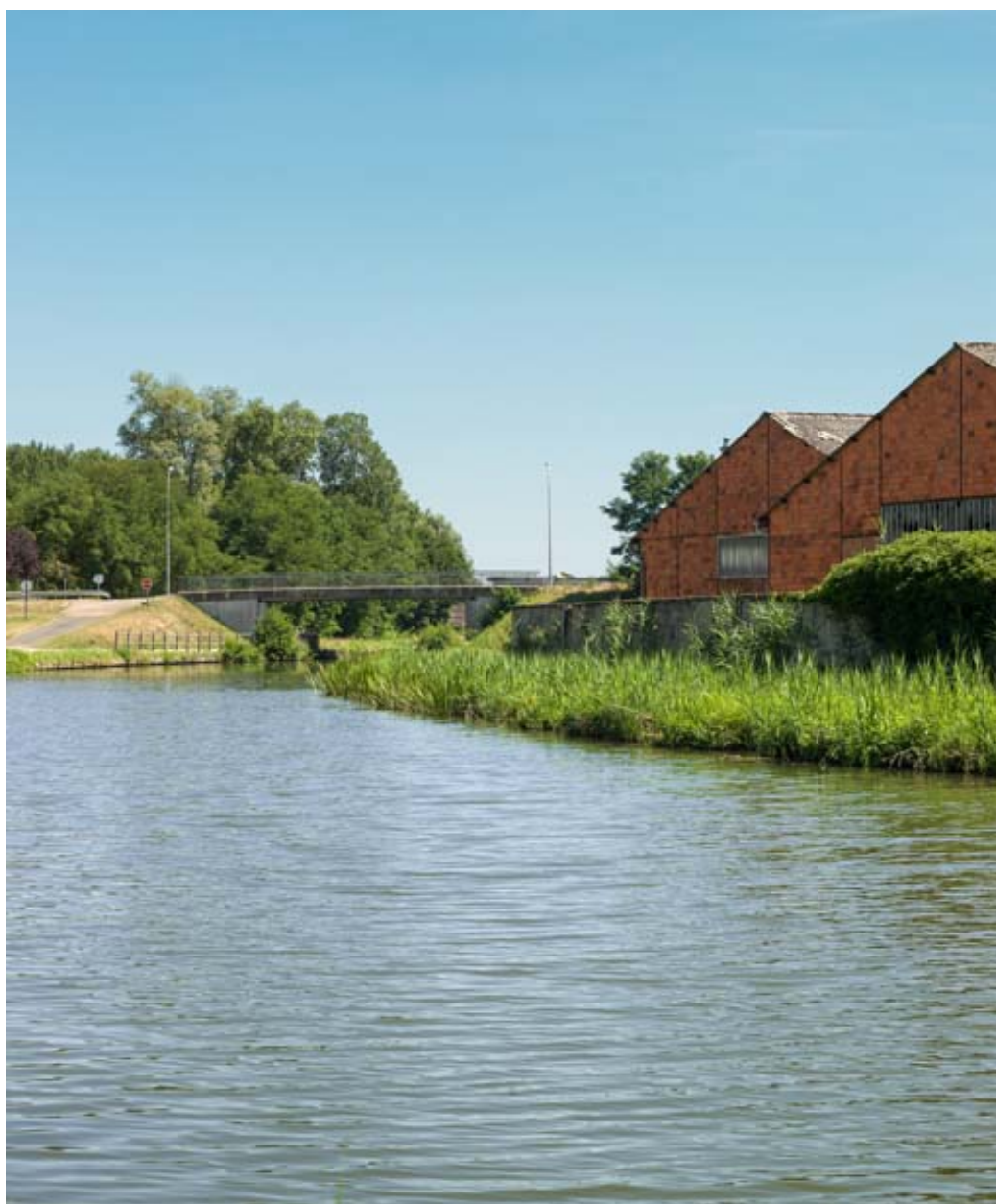
Vue générale du pont et du site.
