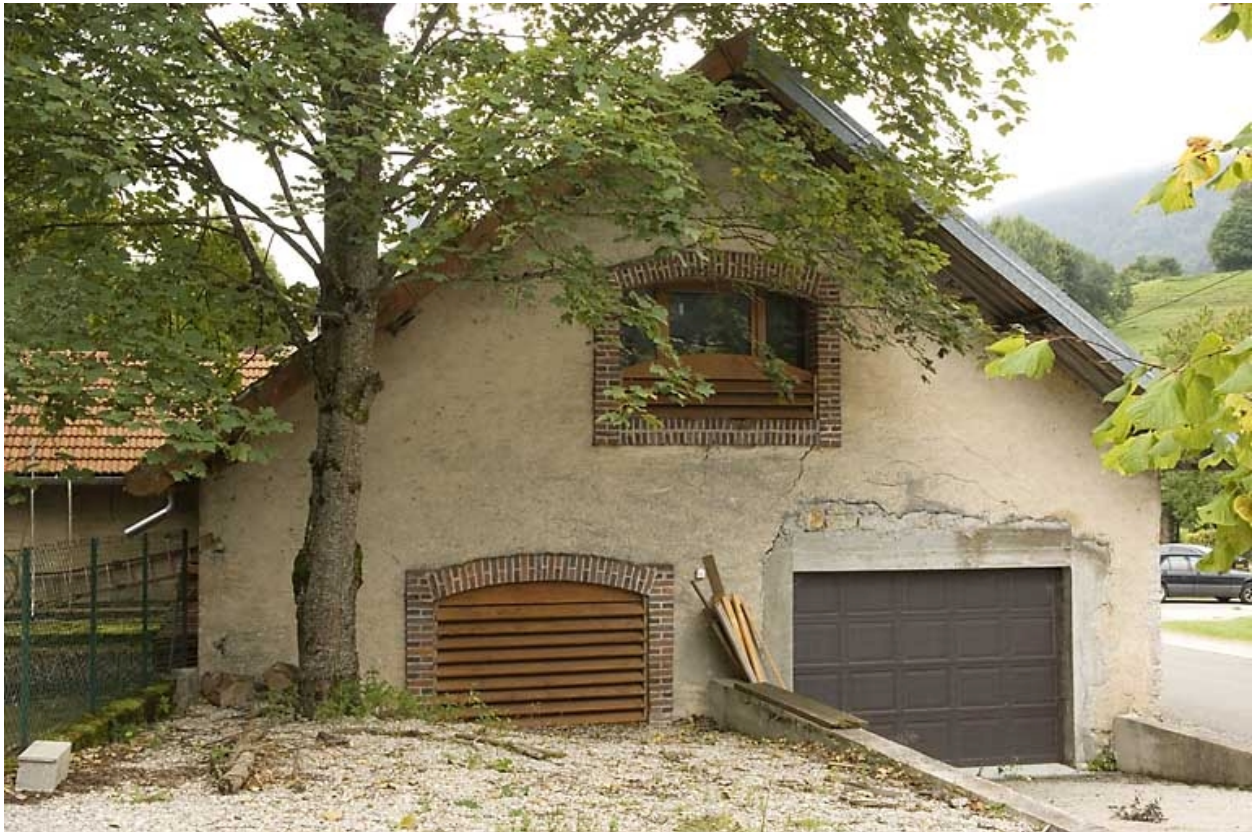
Usine : façade latérale gauche.
