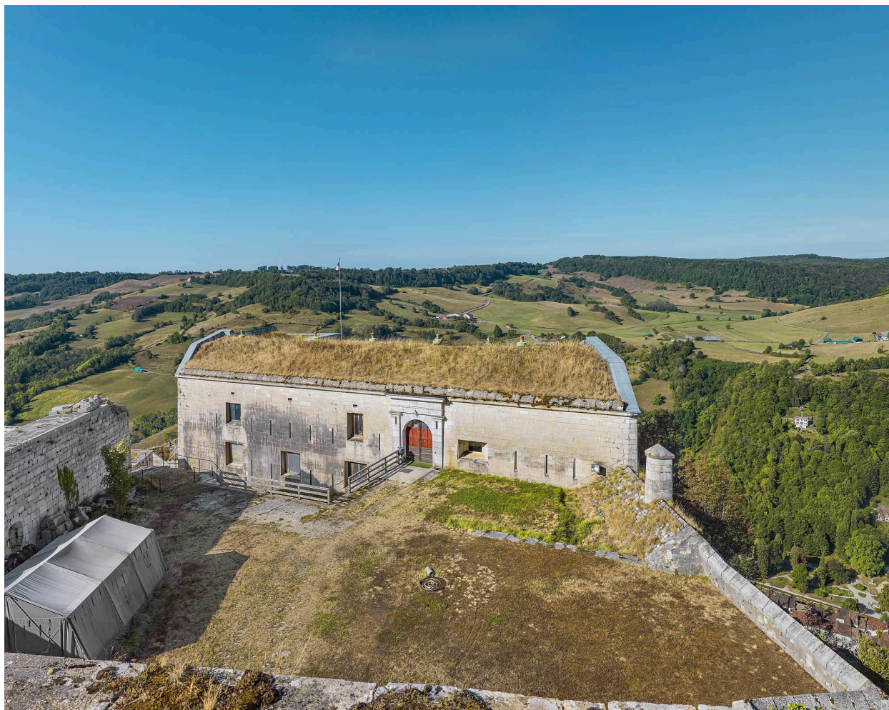
Fort Belin : le réduit.
