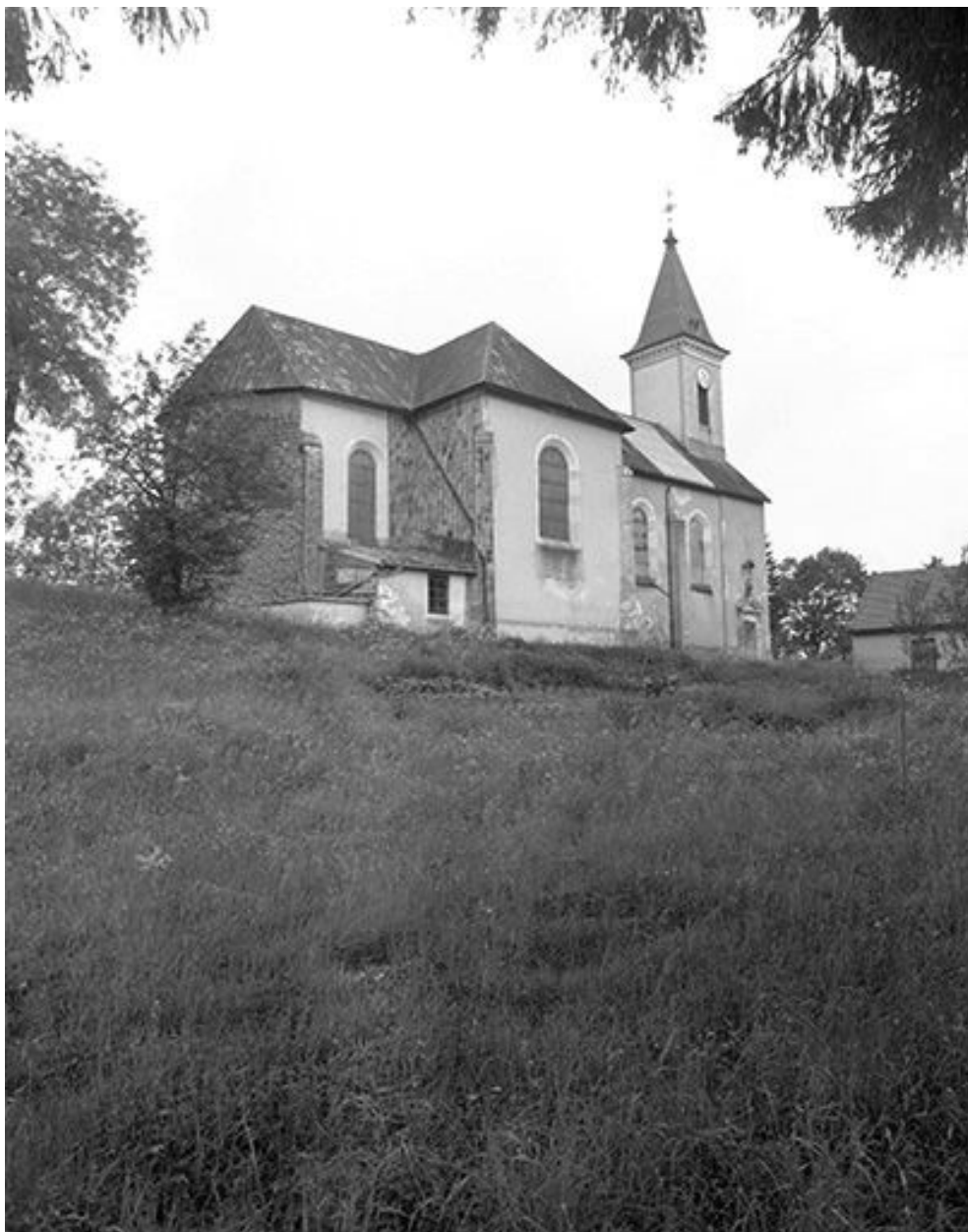
Façade latérale droite.
