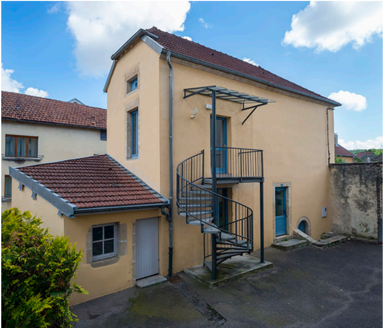
Élévation sur la cour.
