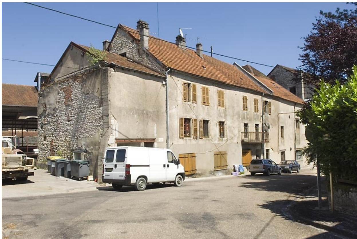
Bâtiment des bureaux et logement.
