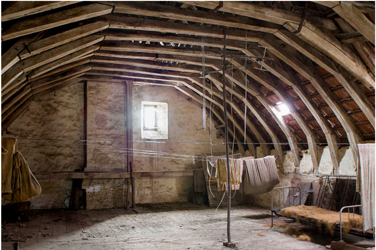
Vue générale de la charpente.
