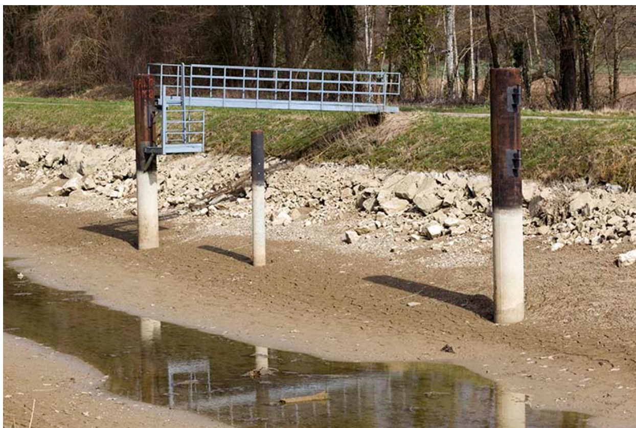
Curage du canal de navigation.
