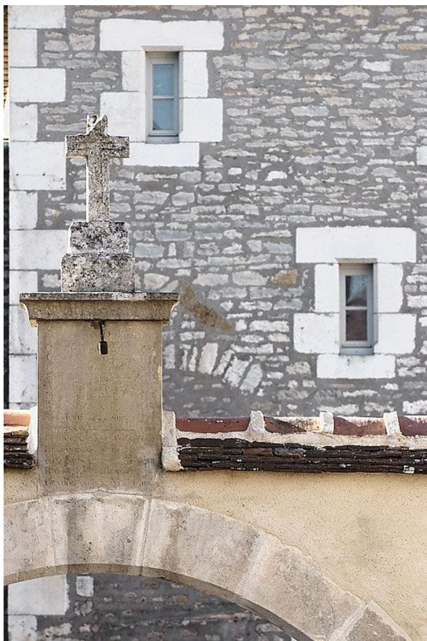
Détail de la croix surmontant le portail.
