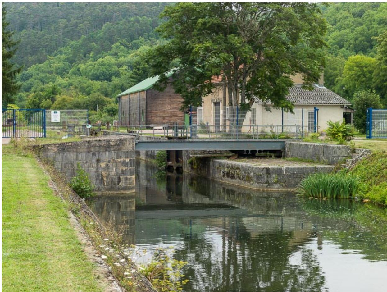
Vue du pont.
