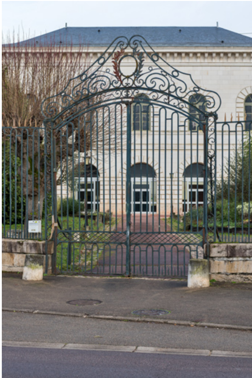
Grille, vue du quai du Général Leclerc (cadrage vertical).
