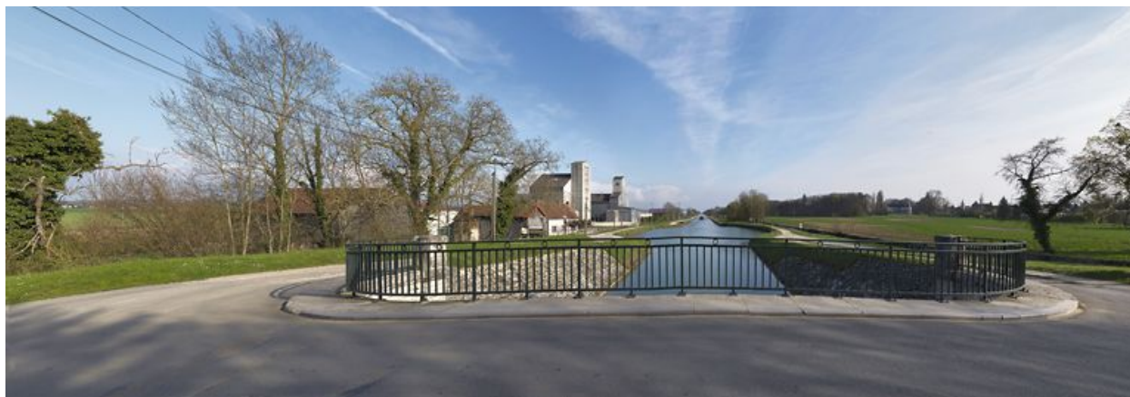
Silos et château de Longecourt vus du pont sur écluse.
