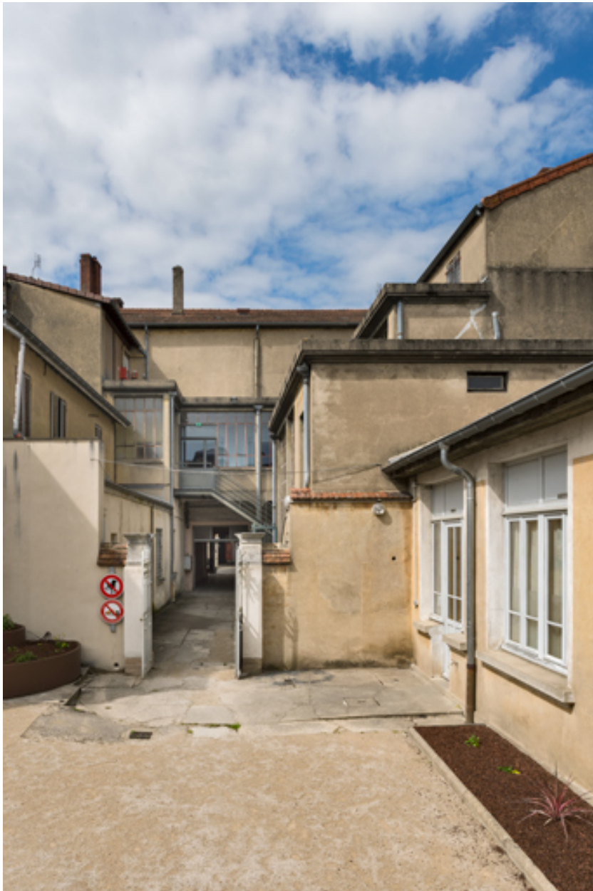
Façade postérieure et dépendances, depuis la deuxième cour au sud.
