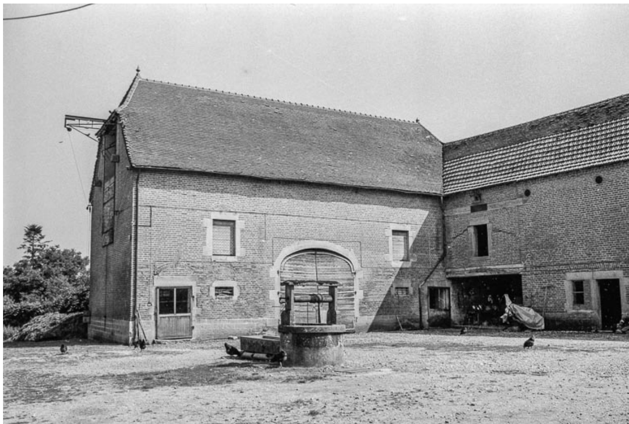
Bâtiment d'exploitation : vue rapprochée..
