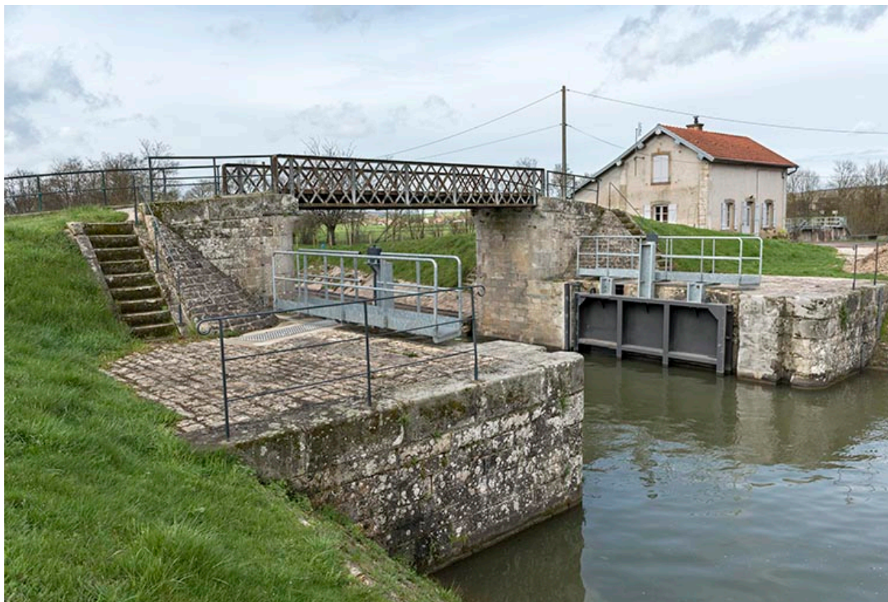
Porte de garde, passerelle et maison du garde, vues de la rive gauche en amont (bief de Cendrecourt) à Bétaucourt (70).
