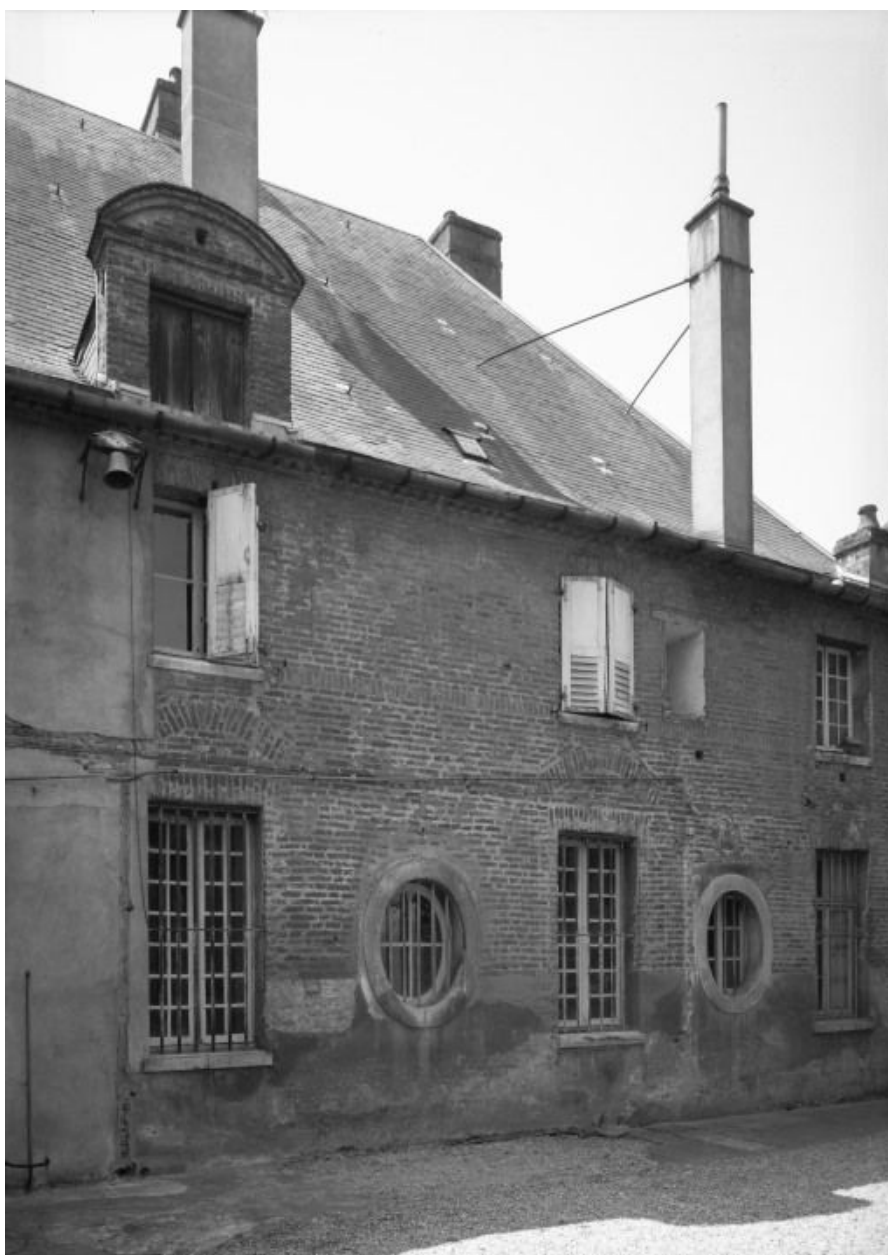
Mur postérieur du corps de logis.
