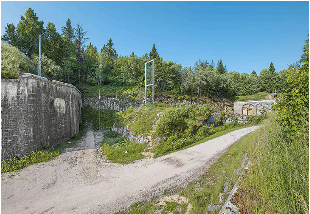
Fort des Rousses : tenaille défendant l'accès à la porte de France.
