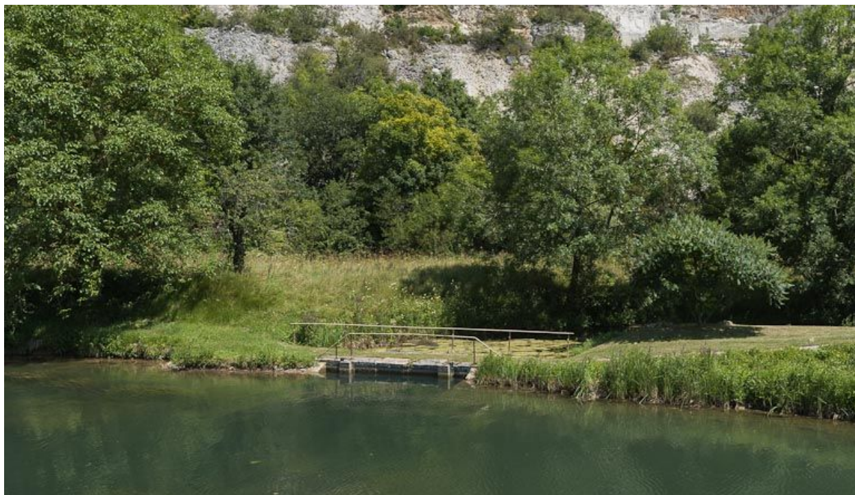
Arrivée de la rigole dans le canal.
