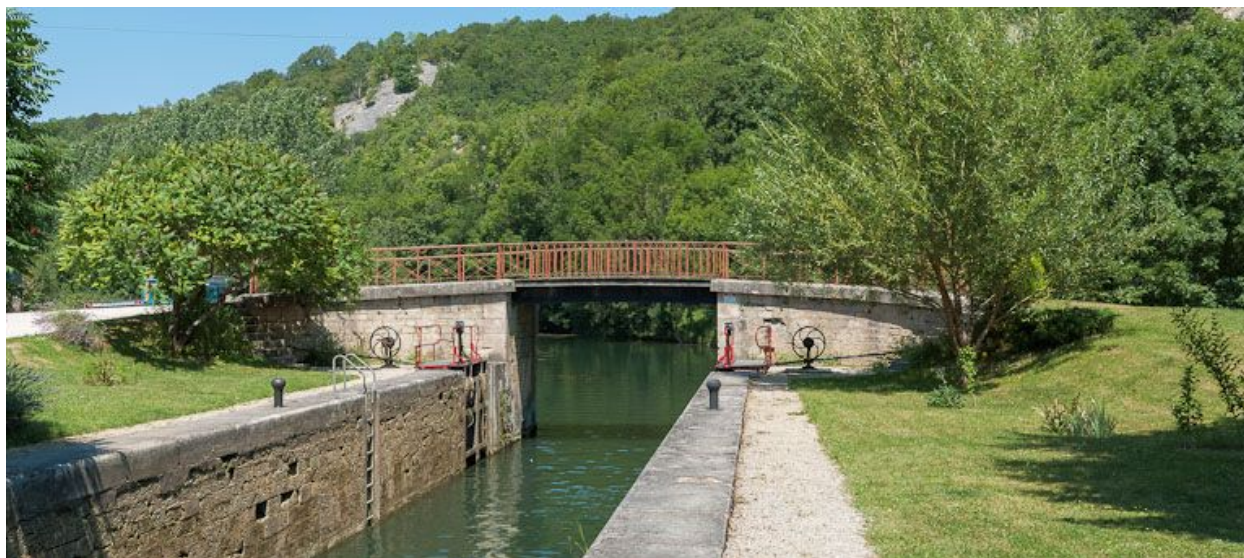
Pont vu du sas.
