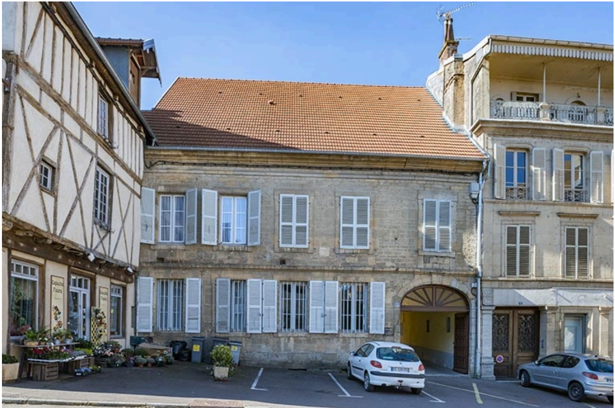
La façade de la maison.
